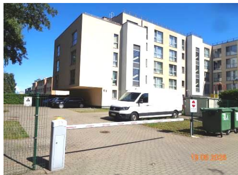
Barjera pie iebrauktuves autostāvvietā pie Ēkas
